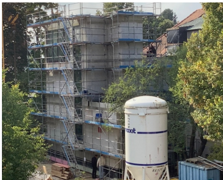
fertiger Rohbau des Treppenturm © Bilder: TBD, Frank Hasse
